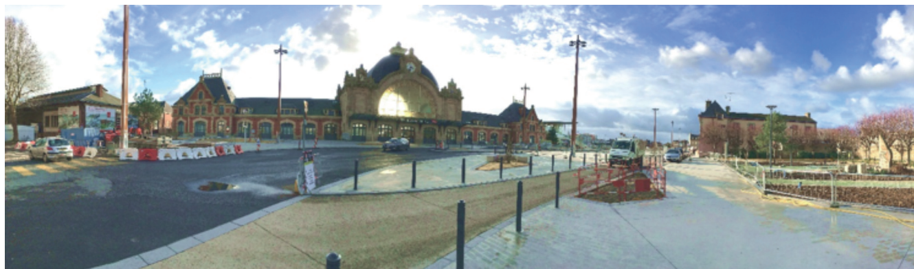
Chantier du pôle d'échanges de la gare de Saint-Brieuc. Vue sur le bâtiment voyageur, janvier 2019.
